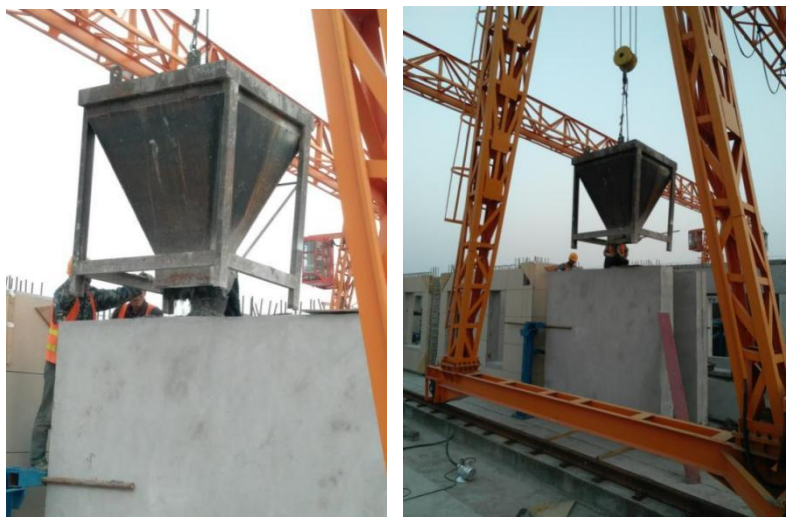
图 16 混凝土浇筑
